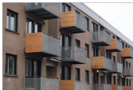
Terrasse Mousseau — Phase II (Habitations communautaires Longueuil) 87 logements pour familles et petits ménages Vieux-Longueuil Architecture : Groupe des Sept
