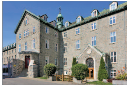
Maison mère des Hospitalières de Saint-Joseph Réaménagement de la maison mère / 50 chambres Plateau Mont-Royal Architecture : ACDF
