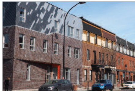
Les Pignons sur rue – Phases II et III (L'Avenue hébergement communautaire) 20 logements pour jeunes avec soutien communautaire Hochelaga-Maisonneuve Architecture : Rayside Labossière
