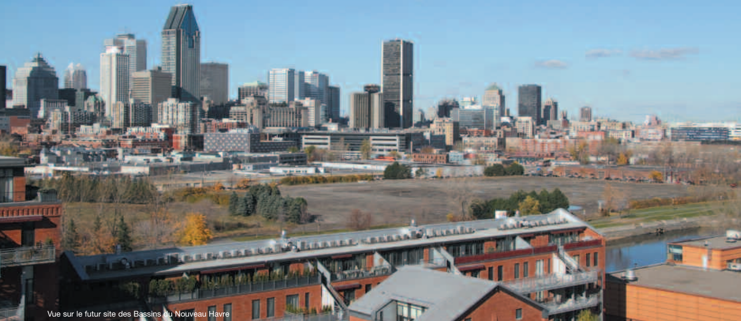
Vue sur le futur site des Bassins du Nouveau Havre
