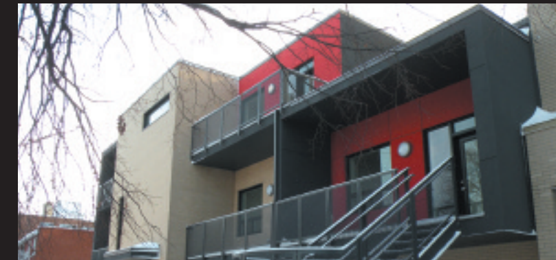
Habitations communautaires Loggia : une seconde vie pour l'Hôpital Bellechasse
