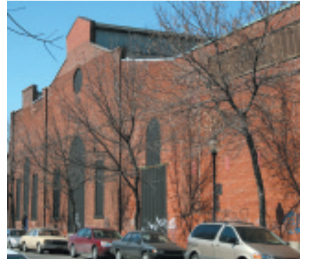
Coopérative Station #1 : la mise en valeur du patrimoine industriel
