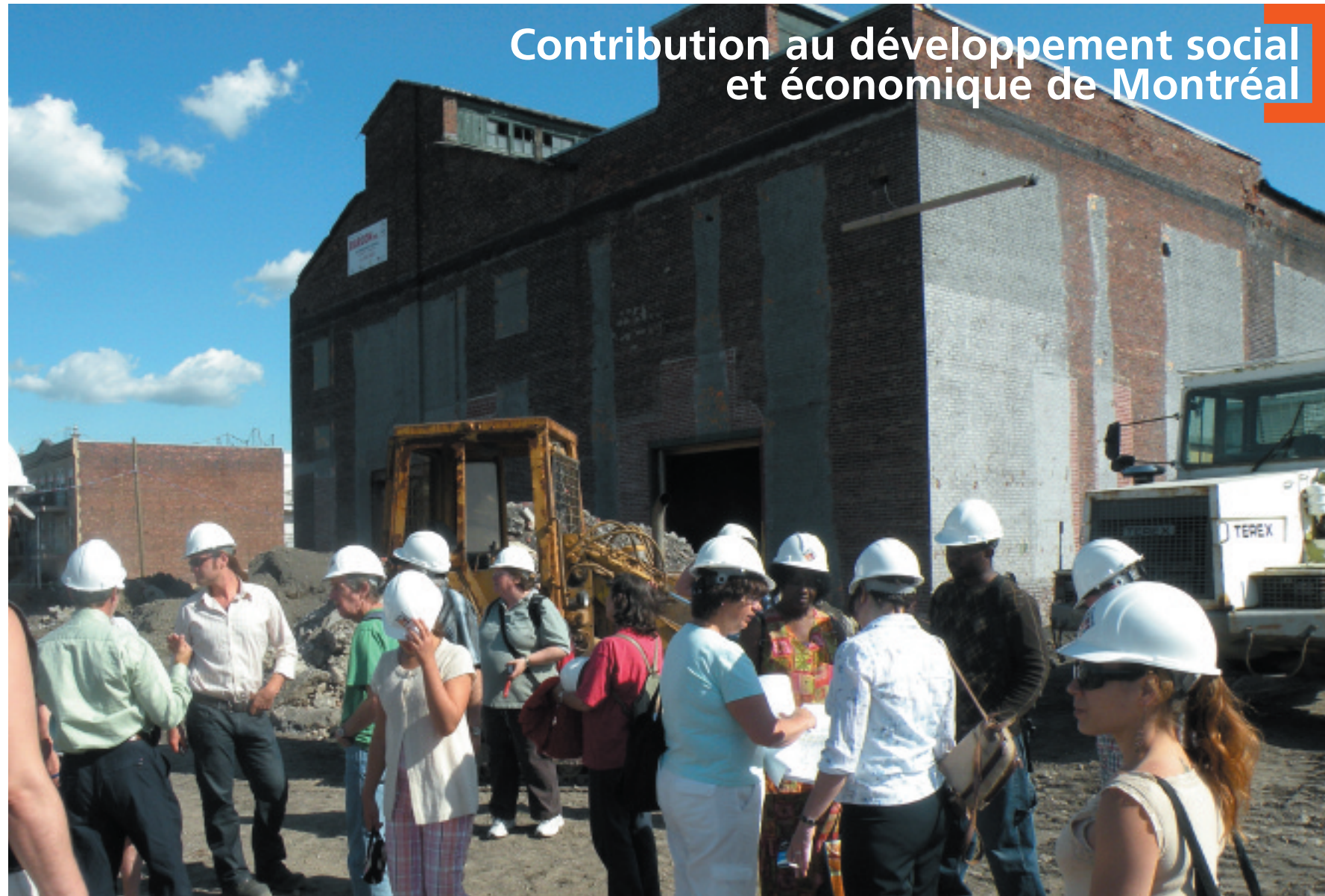
[ Visite de chantier pour les membres de la Coopérative Station #1 ]
